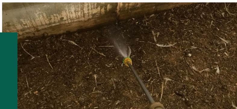
Pulvérisation sur les soubassements du bâtiment
